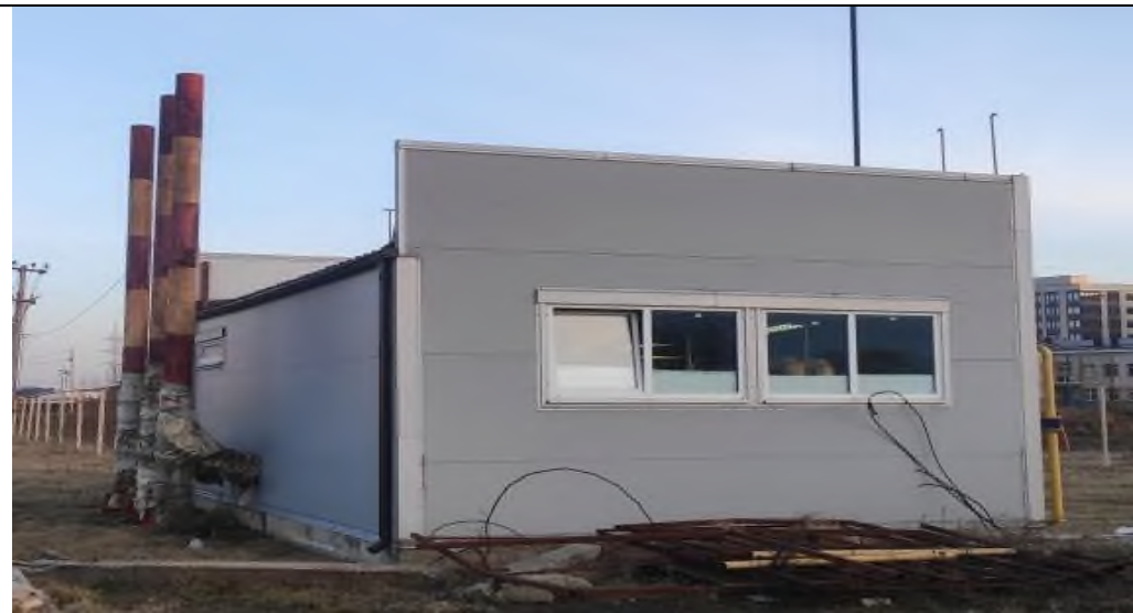
Котельная №2 - аул Новая Адыгея, ул Тургеневское шоссе, 22
