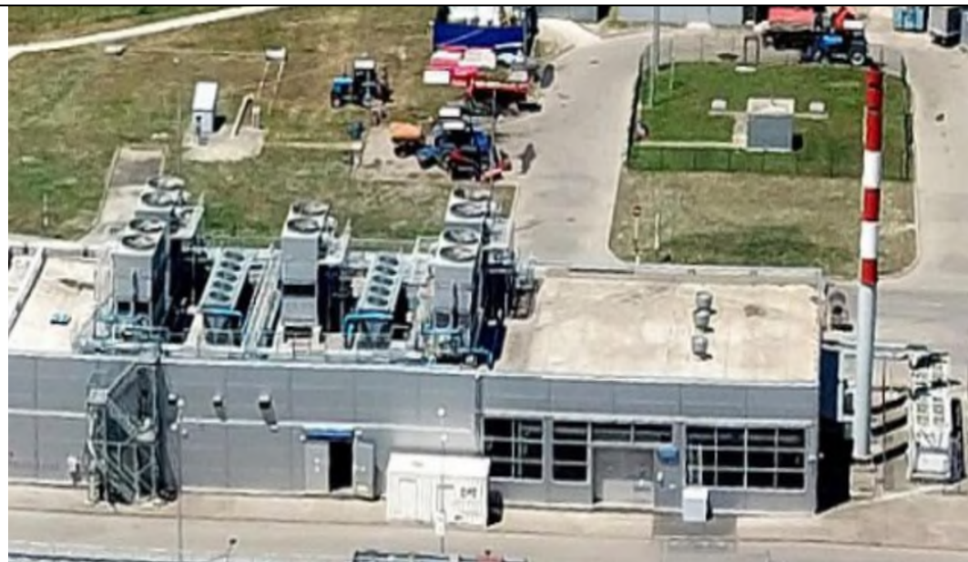
Котельная №5 -а. Новая Адыгея, ул. Тургеневское шоссе, 27
