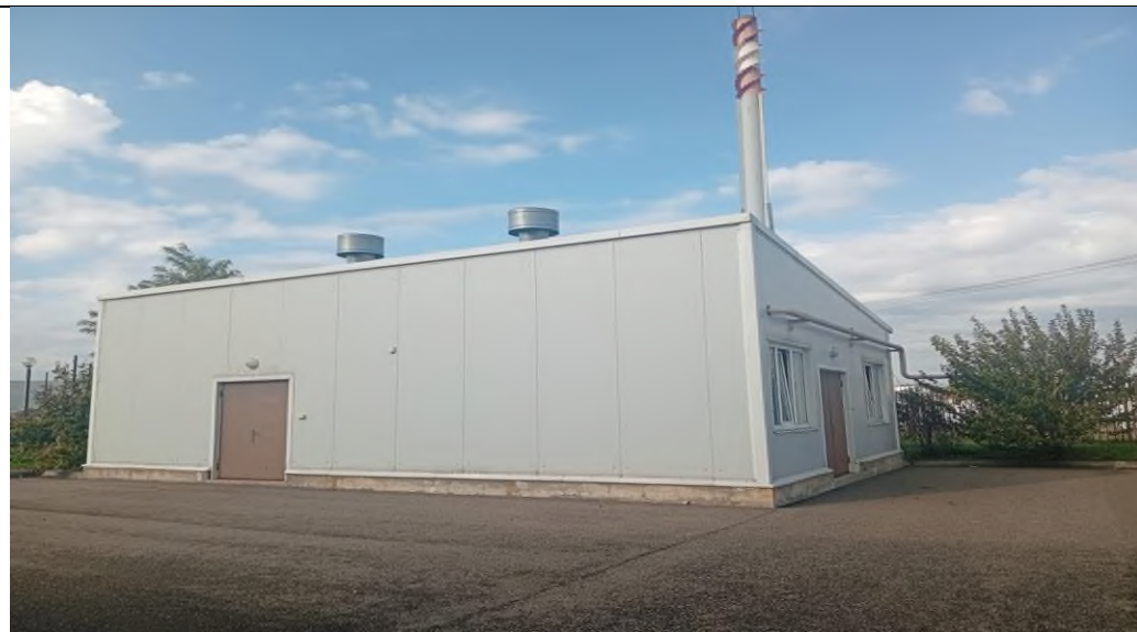
Котельная №10 - аул Новая Адыгея, ул Тургеневское шоссе, 20
