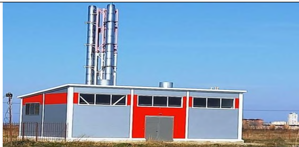
Котельная №8 - а. Новая Адыгея, ул. Тургеневское шоссе, 33/14
