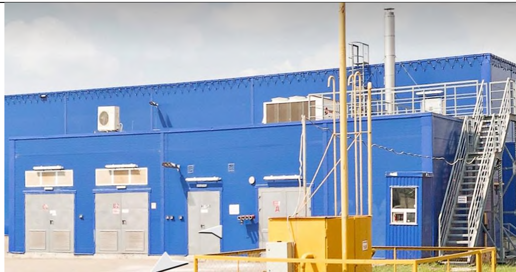
Котельная №1 -а.Новая Адыгея ул.Тургеневское шоссе.27/2
