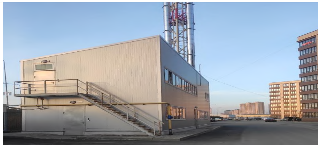
Котельная №7 - а.Новая Адыгея ул.Песочная, 1 корпус 1
